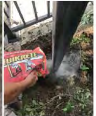
Pour in concrete mix
